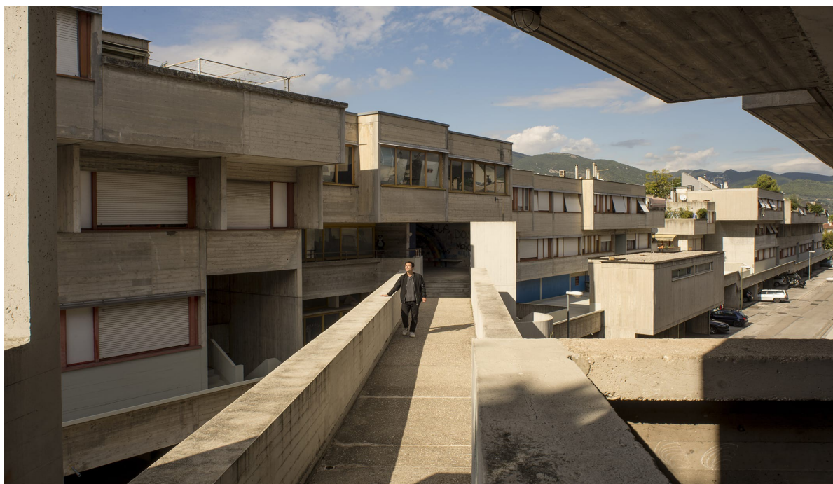
Ilustracja 3: Zabudowa osiedla Matteotti, Terni, arch. Giancarlo De Carlo
